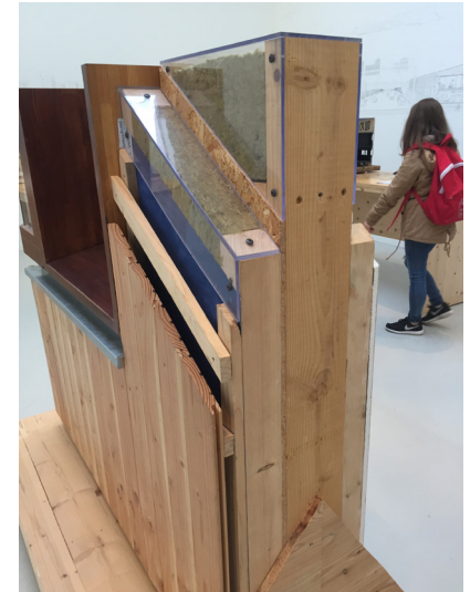
Wandaufbau mit Faserdämmung und Nut- und Federverschalung
